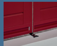
La dardenne sur appui de fenêtre permet le blocage des volets en position fermée.
