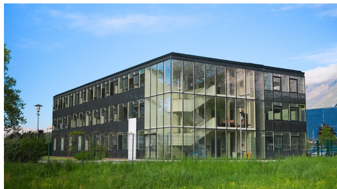
Centre de télésurveillance Atral Services à Crolles (38)
