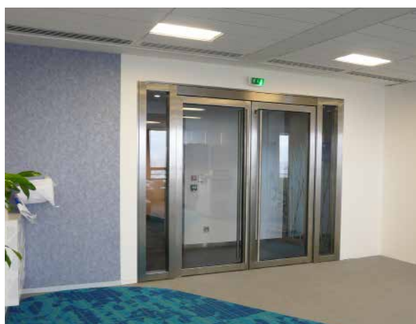
NÉO, avec imposte EI60 RATP, station Mairie de Montrouge (92)
